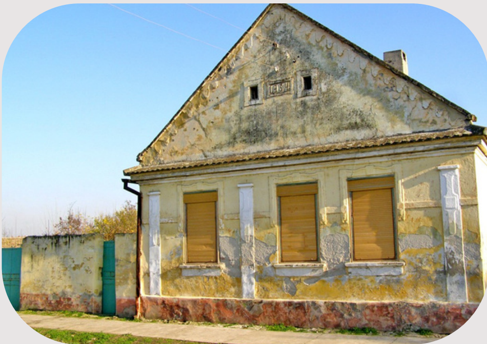
Opovo, Tradicionalna banatska kuća iz 1934. godine, ukrašena stubovima i sa godinom izgradnje na fasadi
